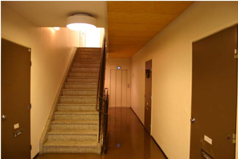
Kuva 25. Käytävän alkuperäinen valaistus.
