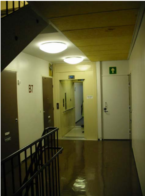
Kuvat 26 ja 27. Käytävän uusi valaistus. Valaisimina 2*24W pyöreitä muovikupuvalaisimia ja 2*36W neliö muovikupuvalaisin.
