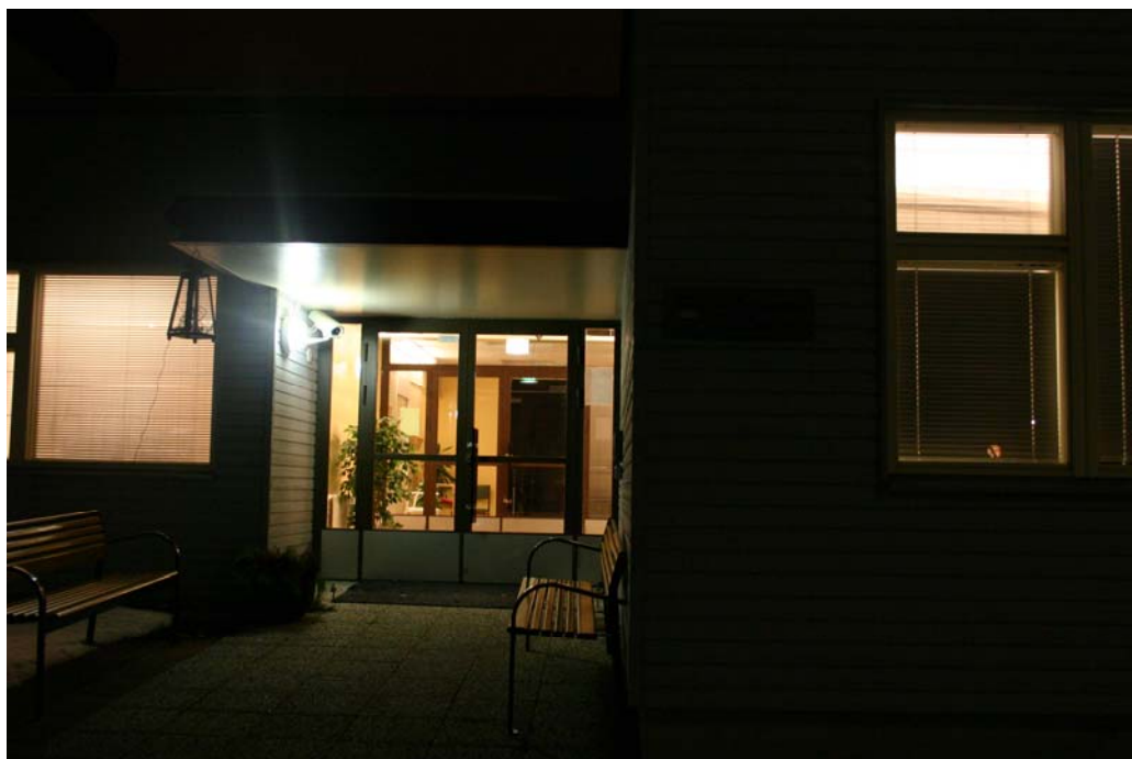
Kuva 7. Ulko-oven luona on riittävä valaistusvoimakkuus, mutta sisäänkäynti ei kuitenkaan erotu julkisivusta.
