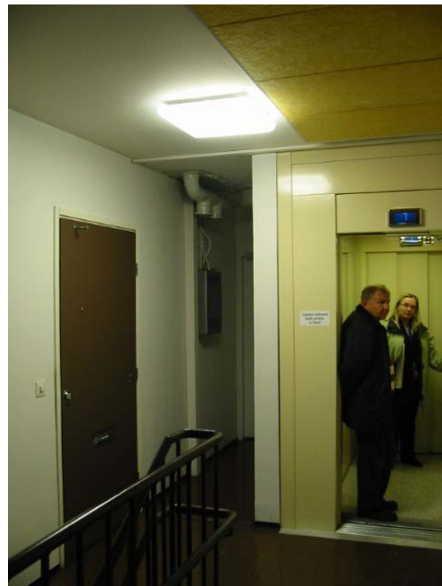
Kuvat 26 ja 27. Käytävän uusi valaistus. Valaisimina 2*24W pyöreitä muovikupuvalaisimia ja 2*36W neliö muovikupuvalaisin.
