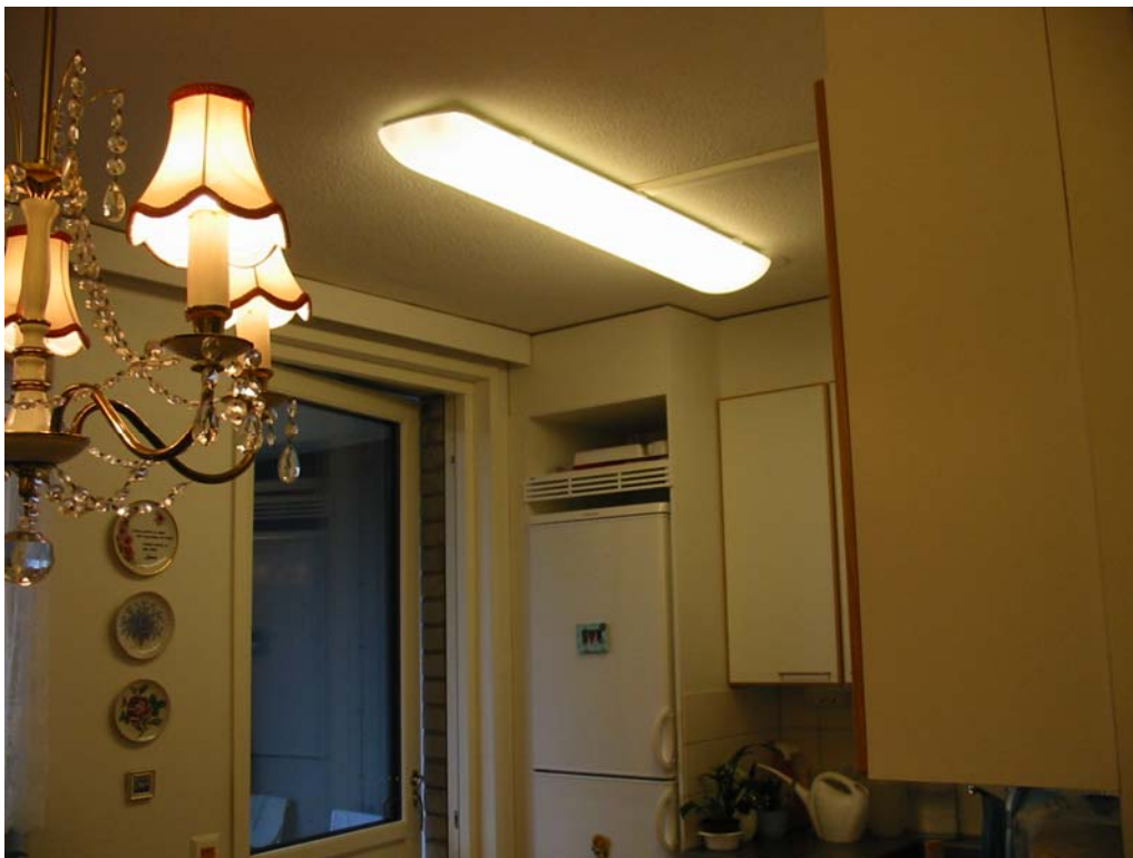
Kuva 22. Keittiön uusi valaistus.
